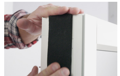
Klistra sedan bandet på de vertikala sidorna av fönstret. Bandet skall vara 2% längre än fönsterkarmens sidor och monteras exakt på fönsterkarmens ned- respektive överkant. Om typ Adjufix, Themahylsa används för montaget, skär ett kryss över hylsan eller använd en hålsåg för att göra hål i bandet. Anpassa storlek och placering på kloss så att den påverkar bandet så lite som möjligt. Säkerställ särskilt tätning emot kloss och att polymerfilmen hålls intakt. (Följ fönstertillverkarens anvisningar om klossar eller distanser används vid fönstermontaget.)
